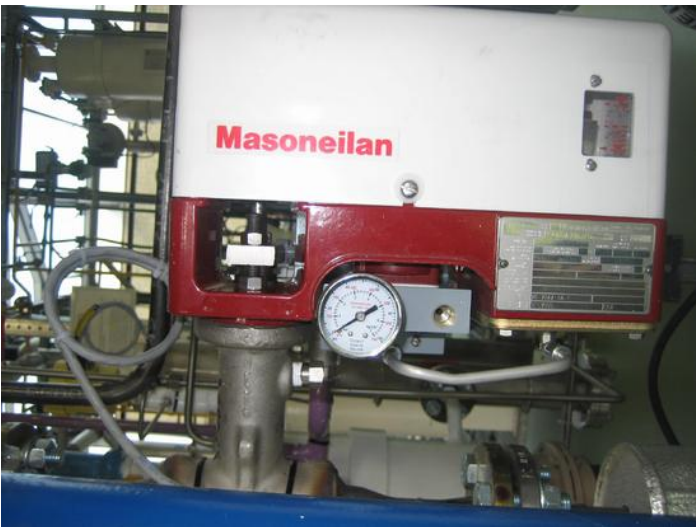
Afbeelding 7 drukregelklep 3PCV-001
