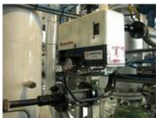
Afbeelding 2: regelklep 2FCV-001, waarmee de voedingflow geregeld wordt.
