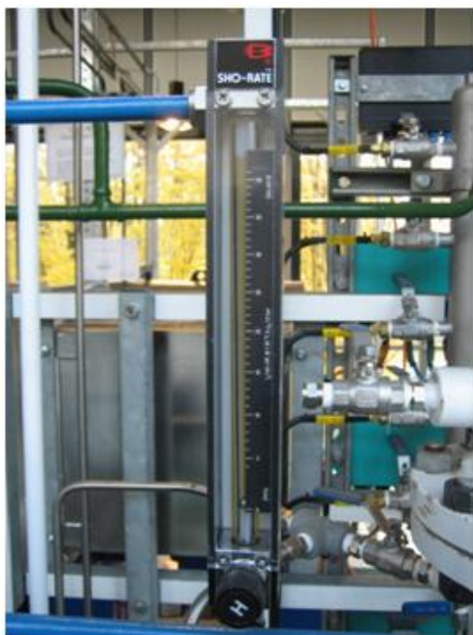
Afbeelding 8: VADO meter, waarmee je de hoeveelheid striplucht instelt.
