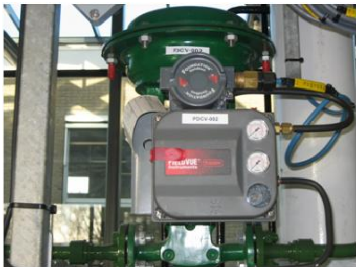
Afbeelding 3: drukregelklep PdCV-002, regelt de druk in kolom C-201
