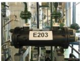
Afbeelding 6: pijpenwarmtewisselaar E-203
